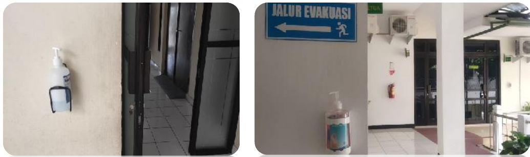
Gambar 4.3 : Penyediaan dan Pemasangan Handsanitizer
