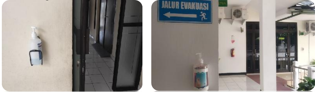
Gambar 4.3 : Penyediaan dan Pemasangan Handsanitizer
